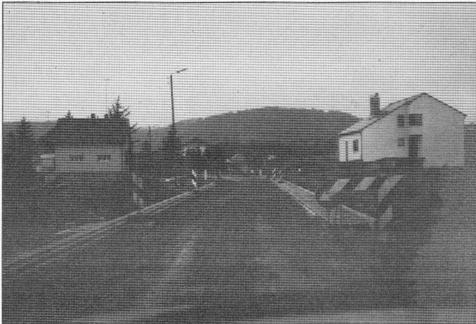
Straßenbauarbeiten in der „Rue Berg“ in Flaxweiler (05. 01. 1989)
