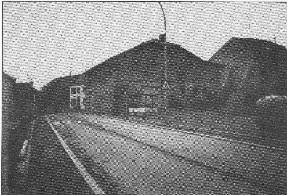
Der Festsaal in Oberdonven vor der Fertigstellung (05. 01. 1989)
