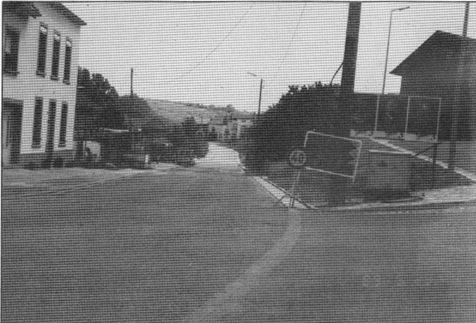
Straßenbauarbeiten in der „Rue des Romains“ und der „Rue de la Moselle“ in Niederdonven (29. 05. 1989)
