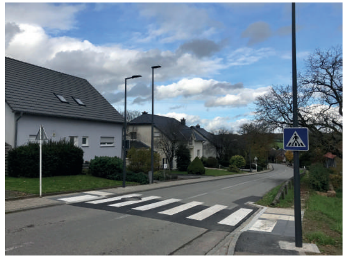
Gostingen, Burgaass - Passage piétons
